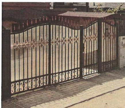
Împrejmuiri din fier forjat cu decorațiuni ne-specifice, dublate cu panou de polycarbonat
