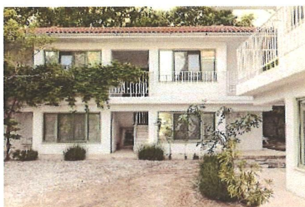
Tratare fațadă cu tencuială fină (Olimp)
