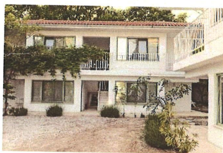
Tratare fațadă cu tencuială fină (Olimp)
